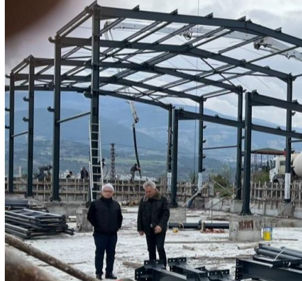
Metalurji Binası, 15 Şubat'24
